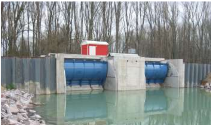
Beispiel: Ein- und Auslaufbauwerk Polder Mechtersheim, RLP
