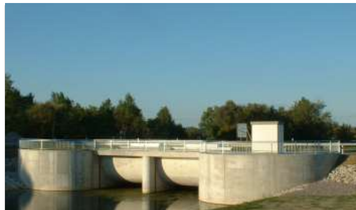
Beispiel: Auslaufbauwerk Polder Söllingen-Greffern, BaWü
